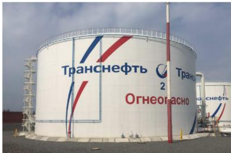
Рисунок 1 – Общий вид резервуара РВС-20000
