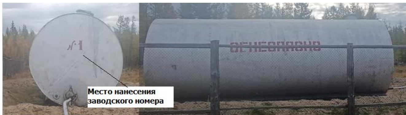
Рисунок 1 – Общий вид резервуара горизонтального стального цилиндрического РГС-50 с указанием места нанесения заводского номера
