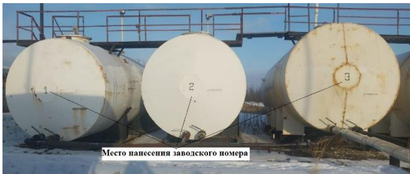
Рисунок 1 – Общий вид резервуаров горизонтальных стальных цилиндрических РГС-50 с указанием места нанесения заводских номеров
