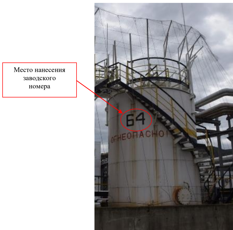
Рисунок 1 – Фотография общего вида резервуара вертикального стального цилиндрического РВС-100 заводской № 64
