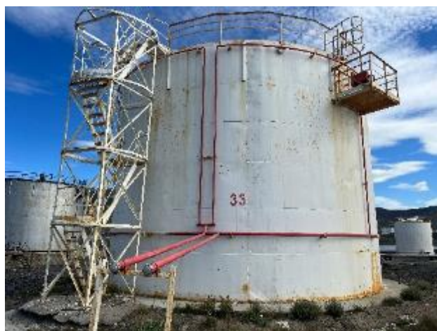
Рисунок 2 – Общий вид резервуара вертикального стального цилиндрического РВС, РВС-1000 зав.№33 с указанием места нанесения заводских номеров
