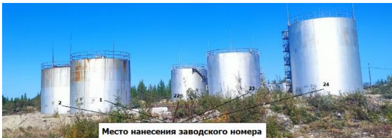
Рисунок 1 – Общий вид резервуаров вертикальных стальных цилиндрических PVC с указанием места нанесения заводских номеров
