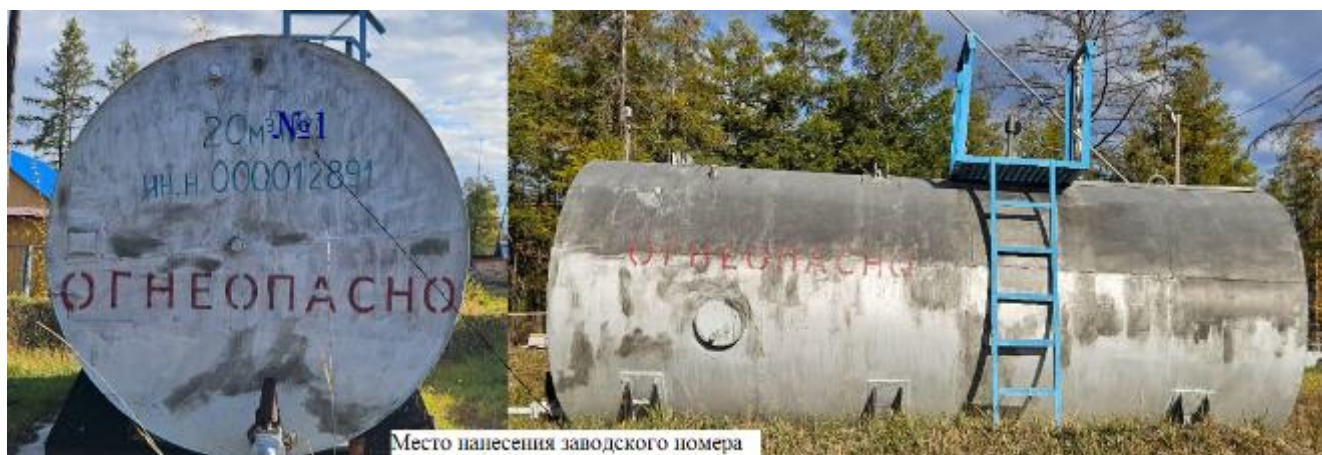
Рисунок 1 – Общий вид резервуара горизонтального стального цилиндрического РГС-20 с указанием места нанесения заводского номера
