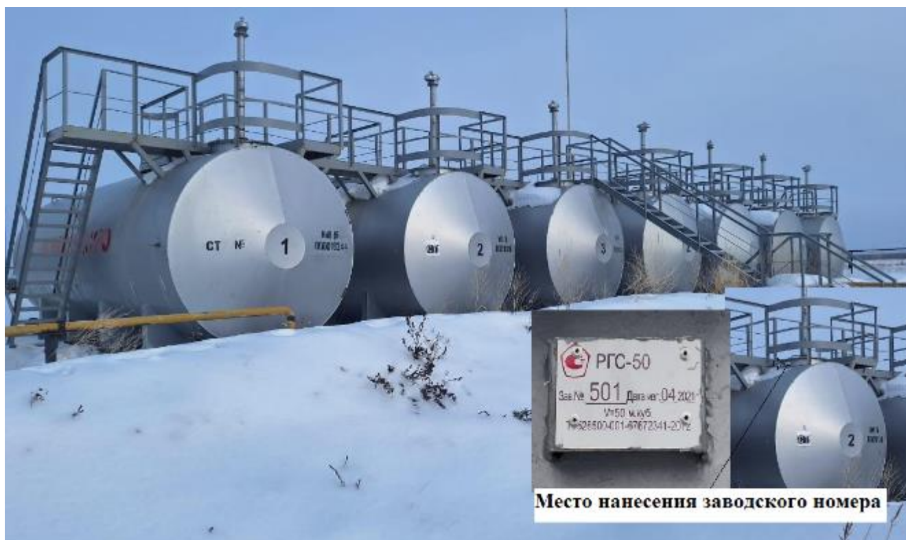
Рисунок 1 – Общий вид резервуаров горизонтальных стальных цилиндрических PGC-50 с указанием места нанесения заводских номеров
