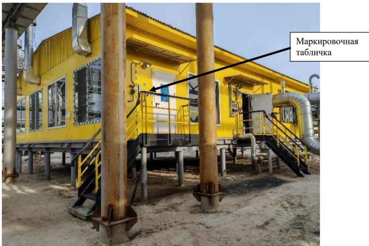
Рисунок 1 – Общий вид СИКН и место крепления маркировочной таблички
