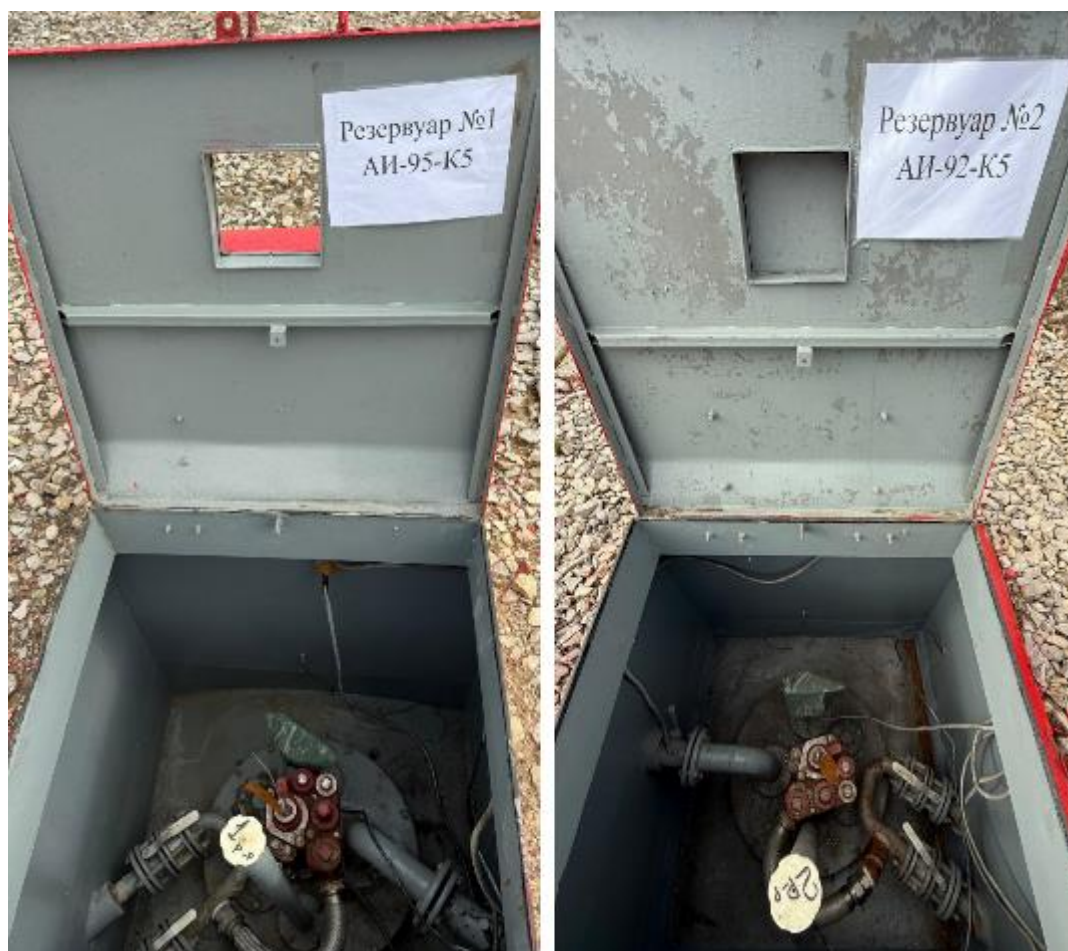
Рисунок 2 – Горловины резервуаров РГС-50 зав.№№ 1, 2
