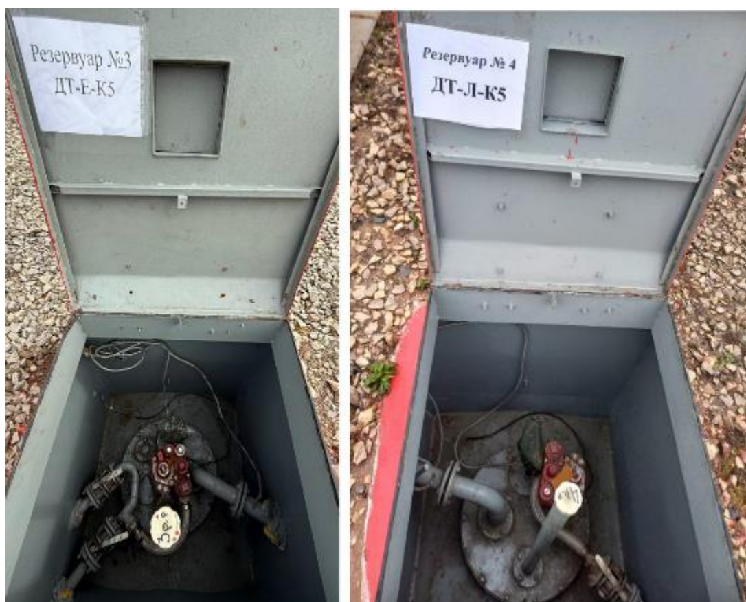
Рисунок 3 – Горловины резервуаров РГС-50 зав.№№ 3, 4
