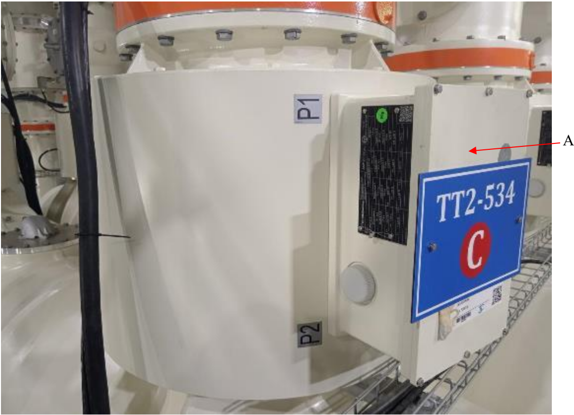
Рисунок 1 – Общий вид средства измерений и обозначение места пломбировки от несанкционированного доступа (А)
