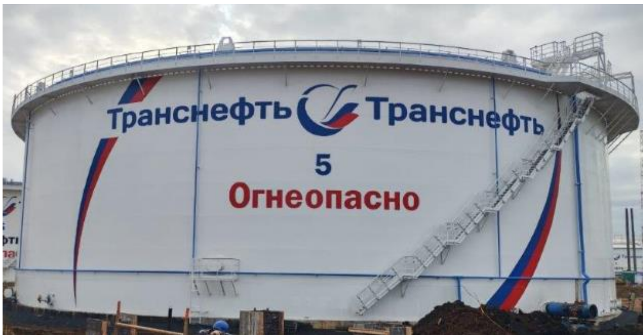
Рисунок 1 – Общий вид резервуара РВСПК-50000 № 5
