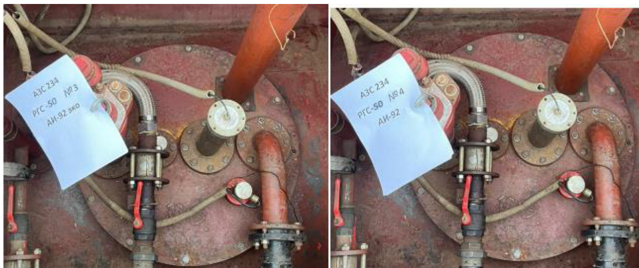
Рисунок 3 – Горловины резервуаров РГС-50 зав.№№ 3, 4
