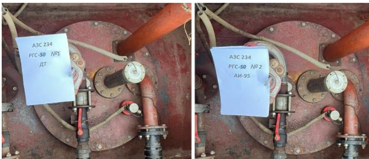
Рисунок 2 – Горловины резервуаров РГС-50 зав.№№ 1, 2
