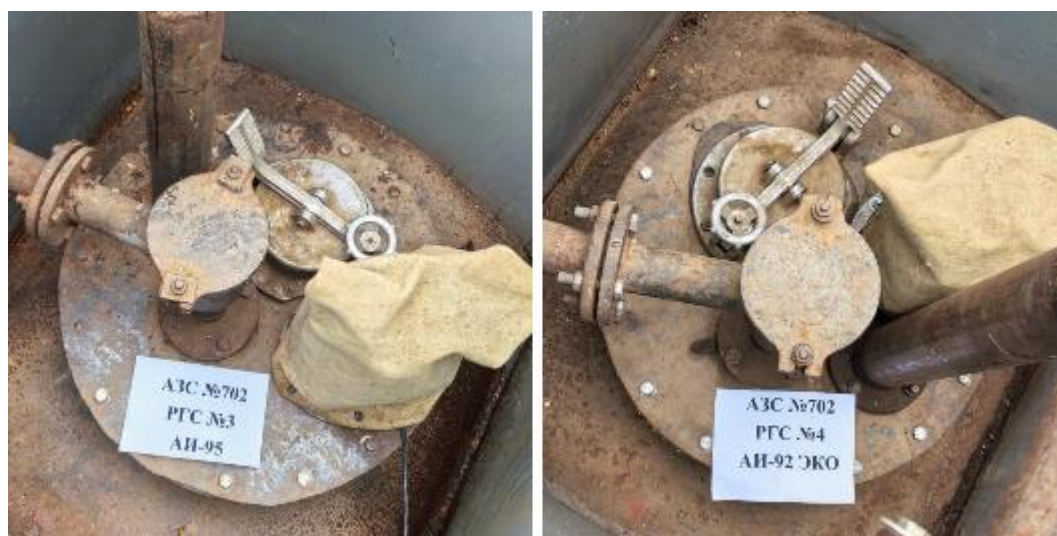
Рисунок 3 – Горловины резервуаров РГС-8 зав.№№ 3, 4
