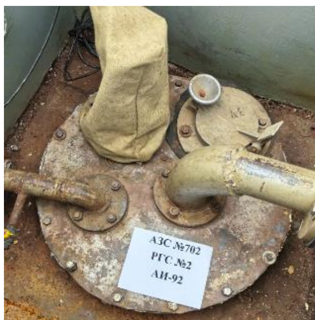
Рисунок 5 – Горловина резервуара РГС-20 зав.№ 2
