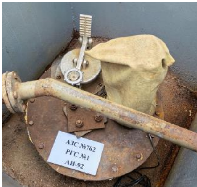
Рисунок 4 – Горловина резервуара РГС-17 зав.№ 1
