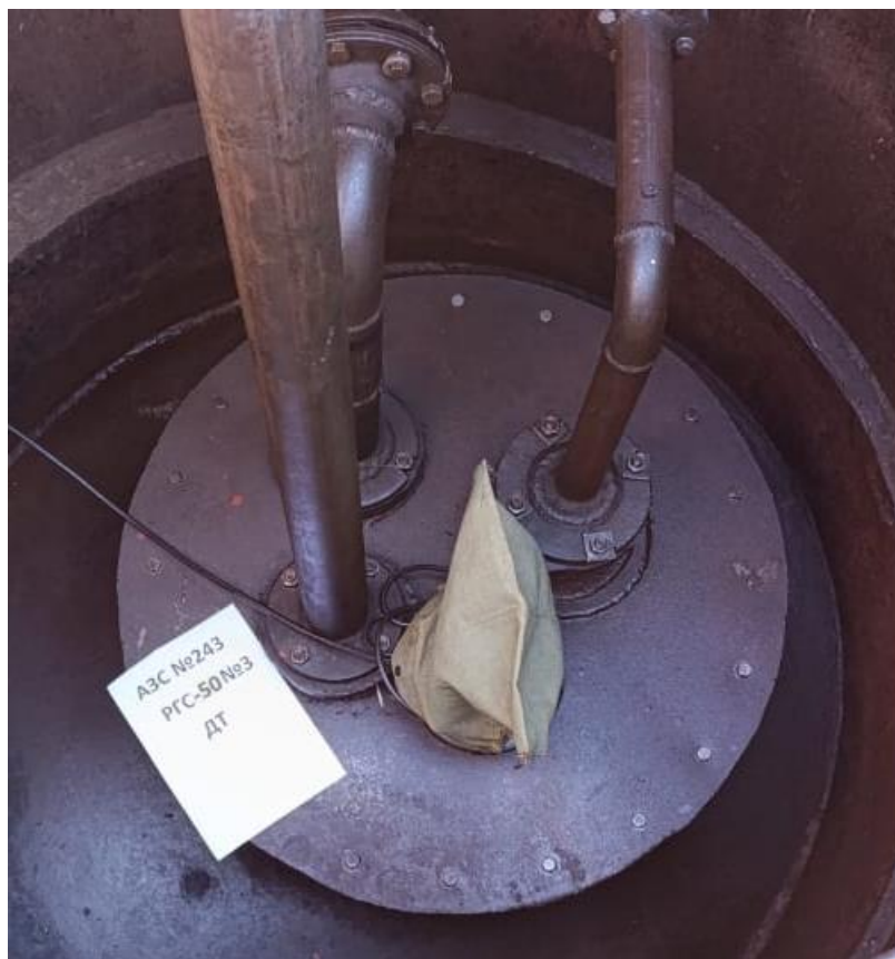
Рисунок 3 – Горловина резервуара РГС-50 зав.№ 3
