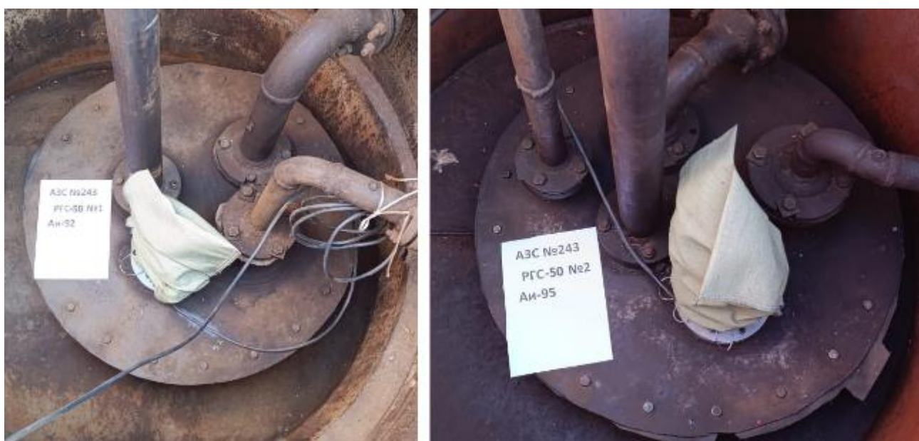
Рисунок 2 – Горловины резервуаров РГС-50 зав.№№ 1, 2
