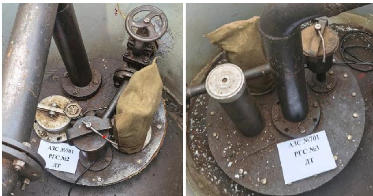
Рисунок 2 – Горловины резервуаров РГС-25 зав.№№ 2, 3
