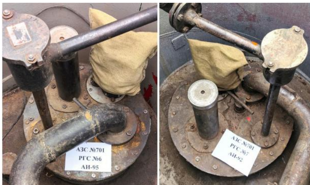
Рисунок 3 – Горловины резервуаров РГС-25 зав.№№ 6, 7
