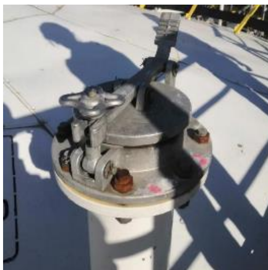
Рисунок 2 – Фотография горловины замерного люка резервуара вертикального стального цилиндрического РВС-10000 заводской № 41
