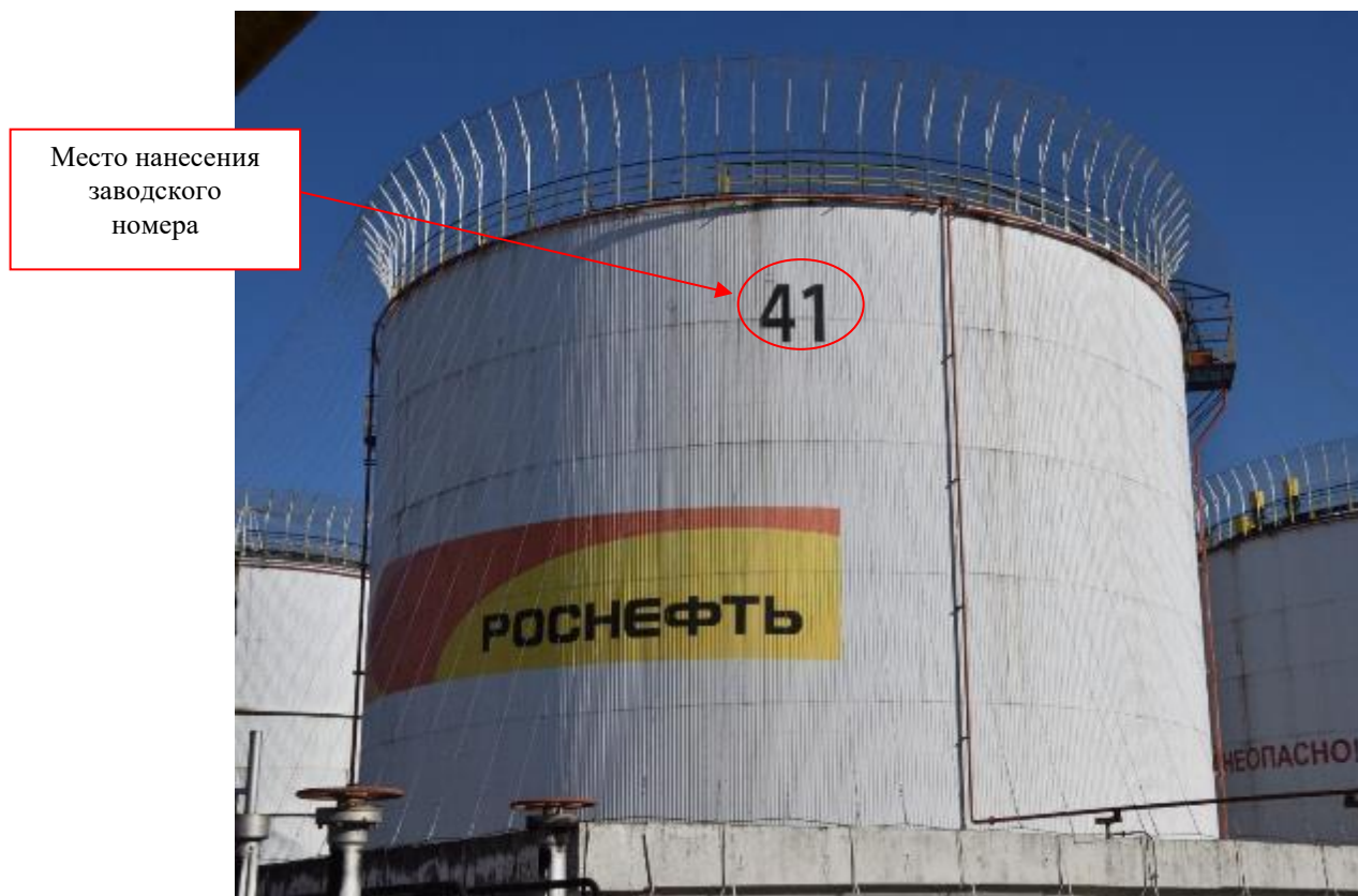
Рисунок 1 – Фотография общего вида резервуара вертикального стального цилиндрического РВС-10000 заводской № 41
