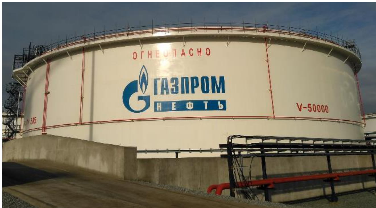
Рисунок 1 – Общий вид резервуара РВСПК-50000 № 505
