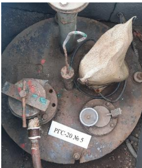
Рисунок 3 – Горловина резервуара РГС-20 зав.№ 5
