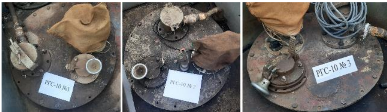
Рисунок 2 – Горловины резервуаров РГС-10 зав.№№ 1, 2, 3
