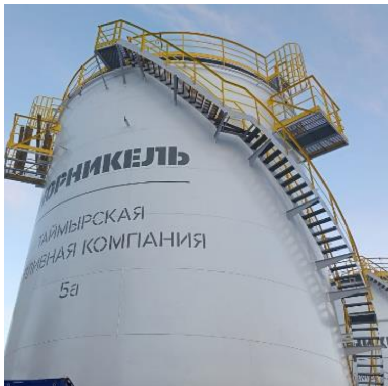
Рисунок 3 – Общий вид резервуара РВСП-1000 № 5а
