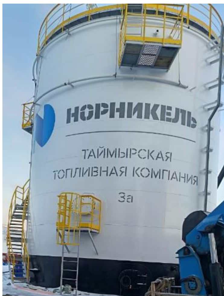
Рисунок 2 – Общий вид резервуара РВСП-1000 № 3а
