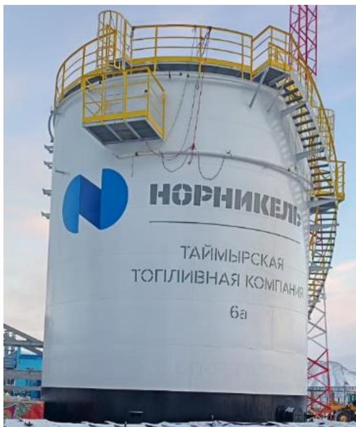
Рисунок 4 – Общий вид резервуара РВСП-1000 № 6а
