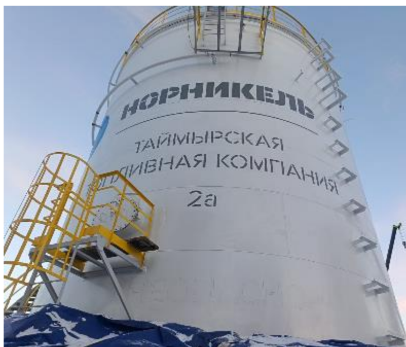
Рисунок 1 – Общий вид резервуара РВСП-1000 № 2а
