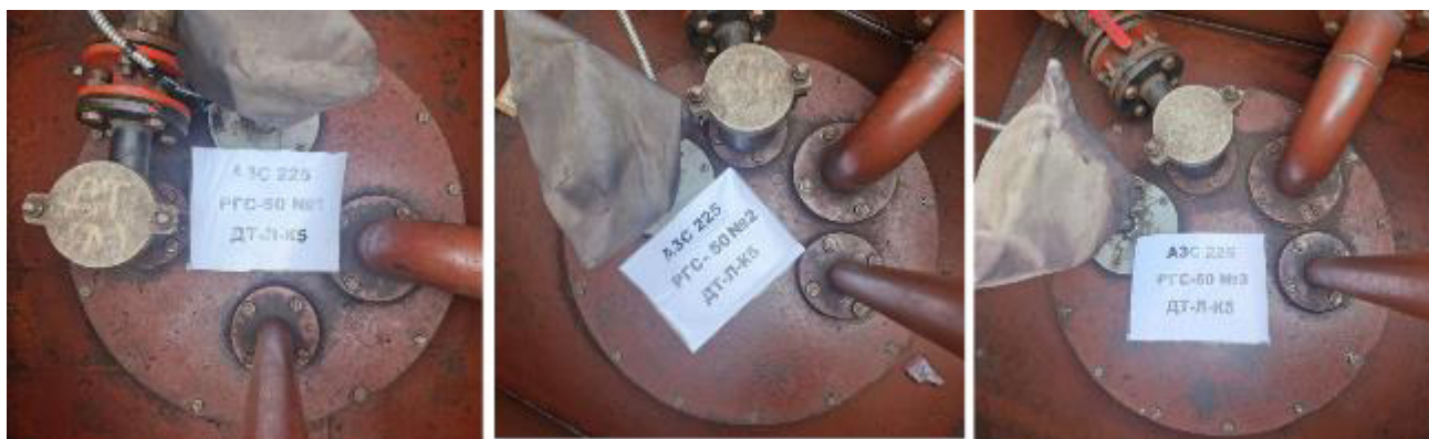
Рисунок 2 – Горловины резервуаров РГС-50 зав.№№ 1, 2, 3
