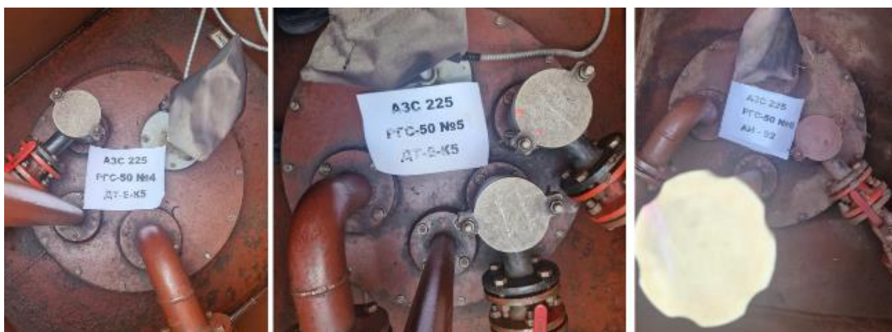
Рисунок 3 – Горловины резервуаров РГС-50 зав.№№ 4, 5, 6
