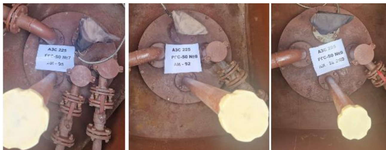
Рисунок 4 – Горловины резервуаров РГС-50 зав.№№ 7, 8, 9
