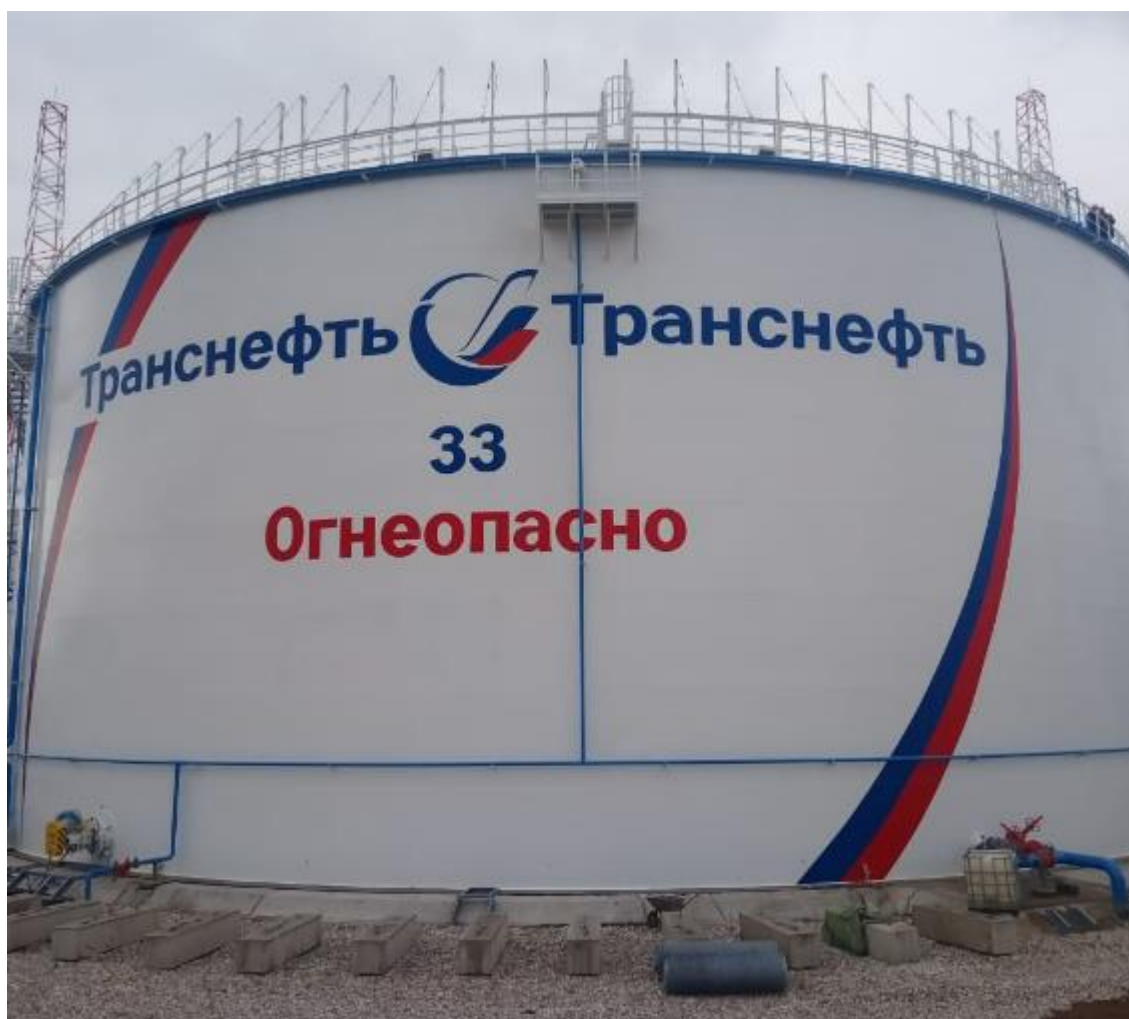
Рисунок 1 – Общий вид резервуара РВСП-30000 № 33
