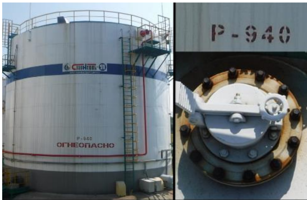
Рисунок 1 – Фотографии общего вида резервуара стального вертикального цилиндрического РВСП-2000 (№Р-940), горловины замерного люка и заводского номера
