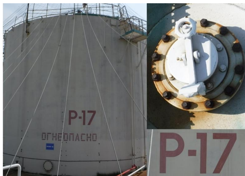
Рисунок 1 – Фотографии общего вида резервуара стального вертикального цилиндрического РВС-2000 (№Р-17), горловины замерного люка и заводского номера
