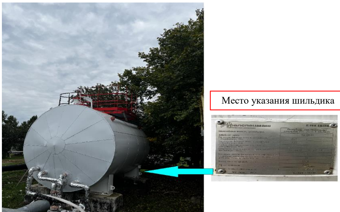
Рисунок 1 – Общий вид резервуара горизонтального стального РГС-25-А-Т-СО-УХЛ1, заводской номер 156.09.21 указан на шильдике
