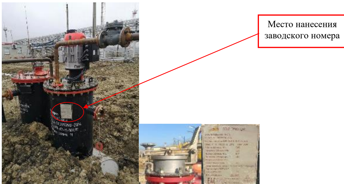
Рисунок 2 – Общий вид заливной горловины, замерного люка и информационной таблички М-ЕП8 зав.№ 2608
