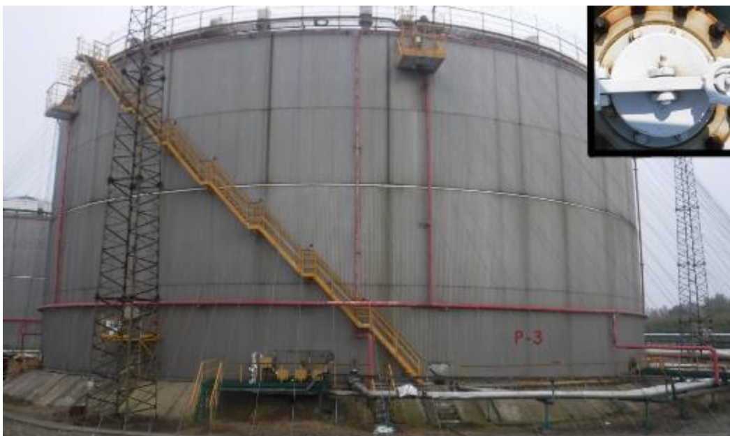
Рисунок 1 – Фотографии общего вида резервуара стального вертикального цилиндрического РВСП-30000 (№Р-3), горловины замерного люка и заводского номера
