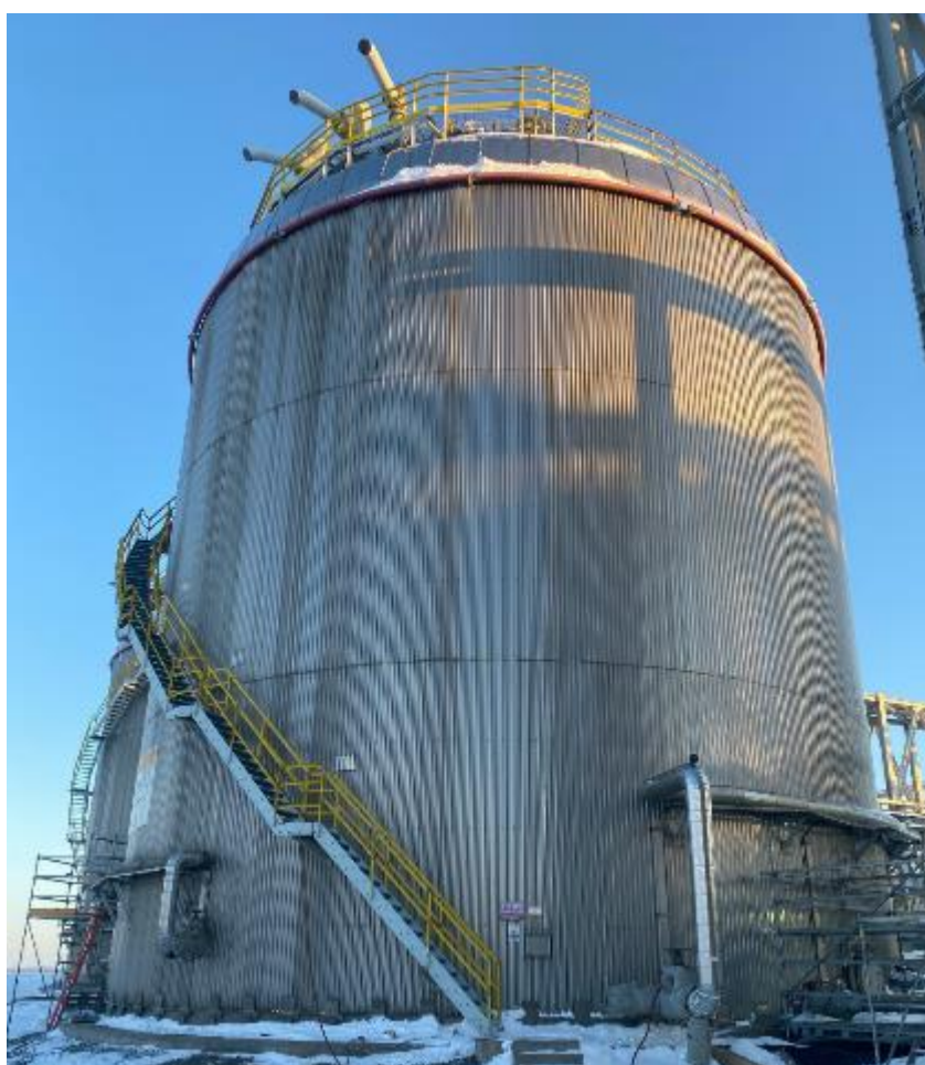
Рисунок 2 – Общий вид резервуара РВС-5000
