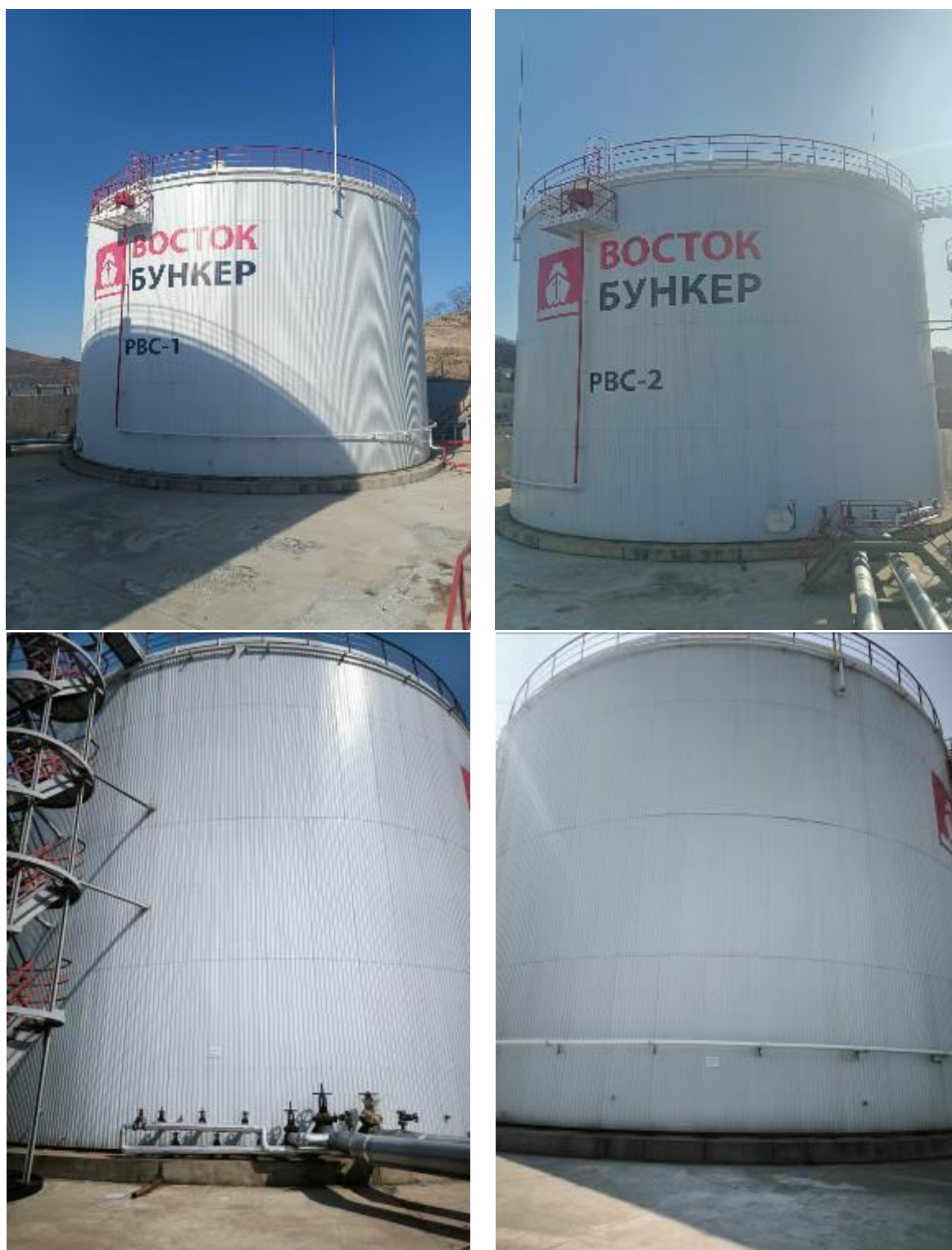
Рисунок 1 – Общий вид резервуаров стальных вертикальных цилиндрических PBC-5000: заводской номер 1 (слева) и заводской номер 2 (справа)
