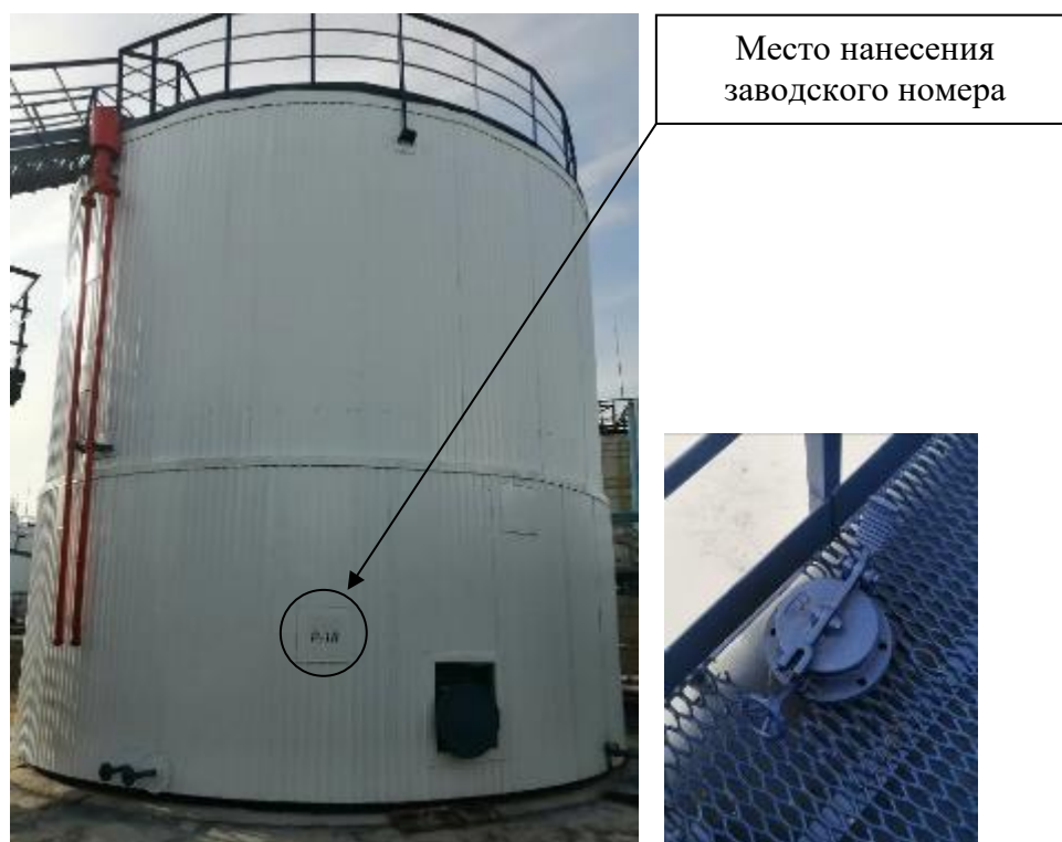
Р и с у н о к 2 – Общий вид резервуара с заводским номером P-18 и его замерного люка
