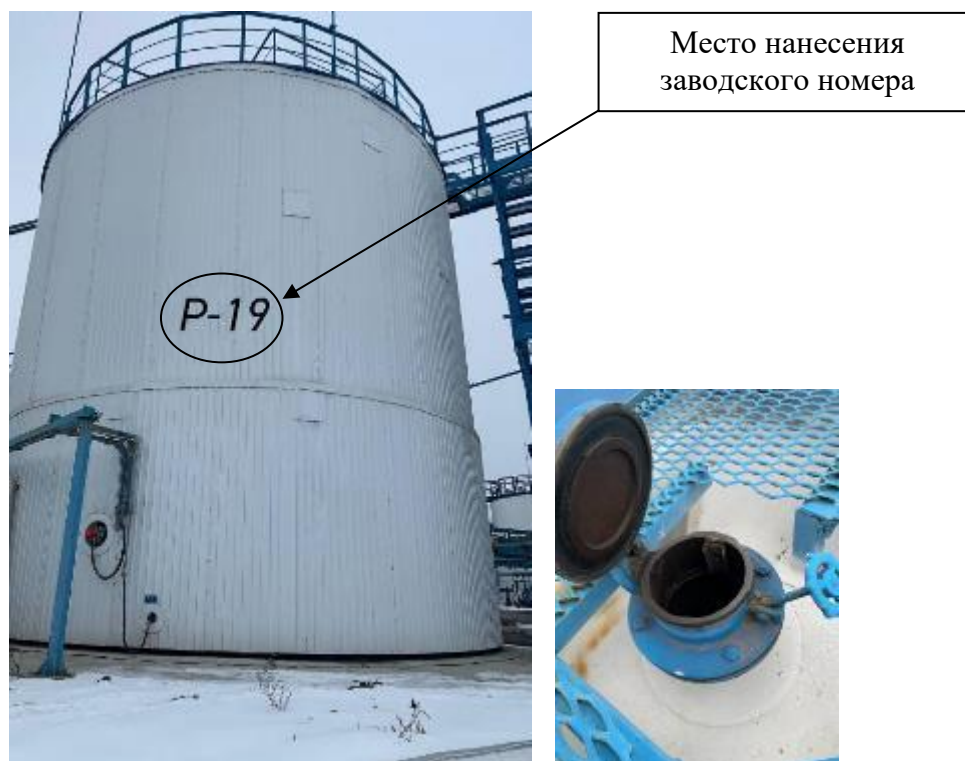
Р и с у н о к 3 – Общий вид резервуара с заводским номером P-19 и его замерного люка
