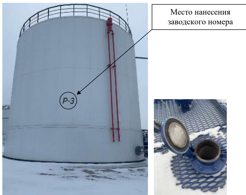
Р и с у н о к 1 – Общий вид резервуара с заводским номером P-3 и его замерного люка
