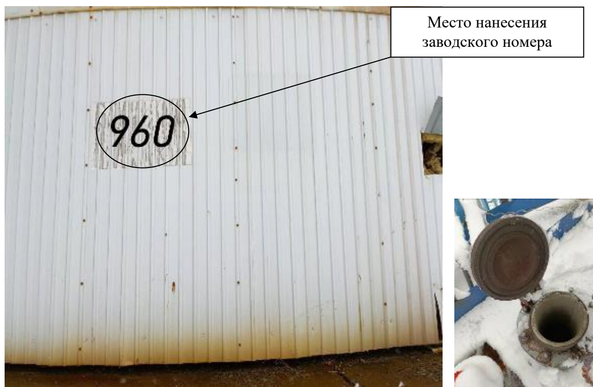
Р и с у н о к 6 – Общий вид резервуара с заводским номером 960 и его замерного люка
