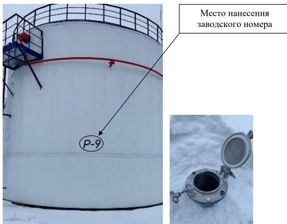
Р и с у н о к 3 – Общий вид резервуара с заводским номером P-9 и его замерного люка
