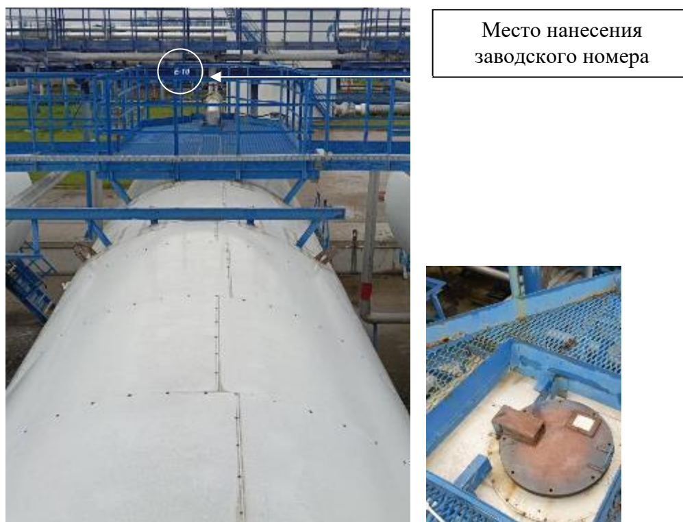
Р и с у н о к 4 – Общий вид резервуара с заводским номером Е-10 и его замерного люка
