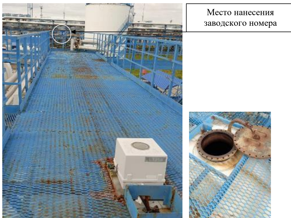
Р и с у н о к 3 – Общий вид резервуара с заводским номером Е-8 и его замерного люка
