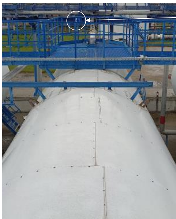
Р и с у н о к 1 – Общий вид резервуара с заводским номером E1 и его замерного люка
