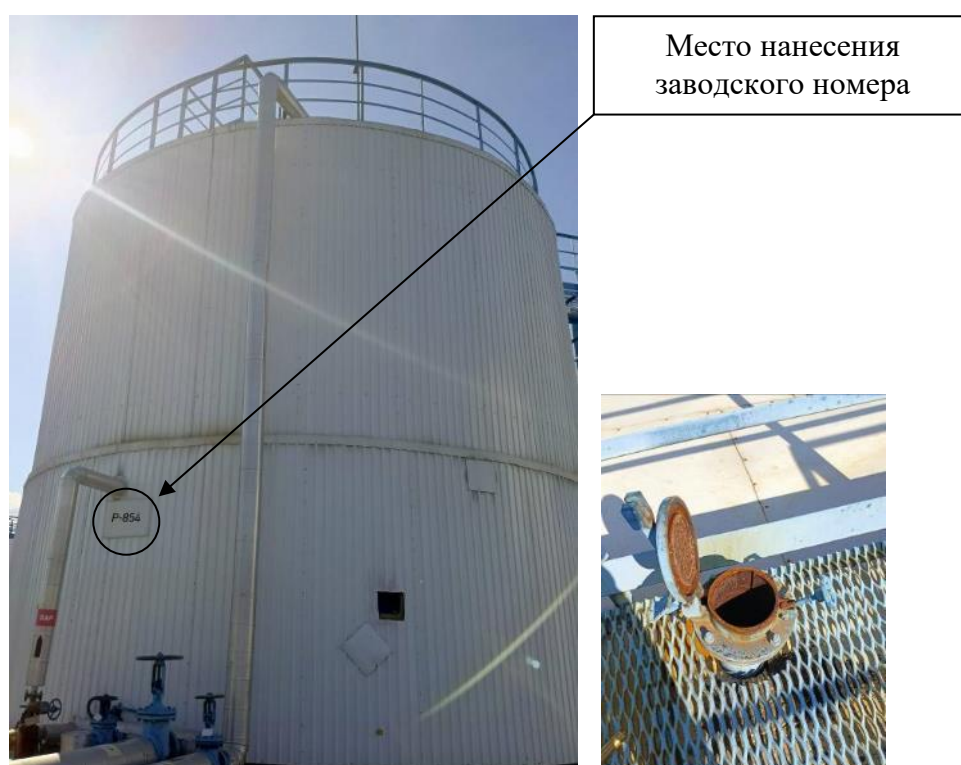
Р и с у н о к 2 – Общий вид резервуара с заводским номером P-854 и его замерного люка
