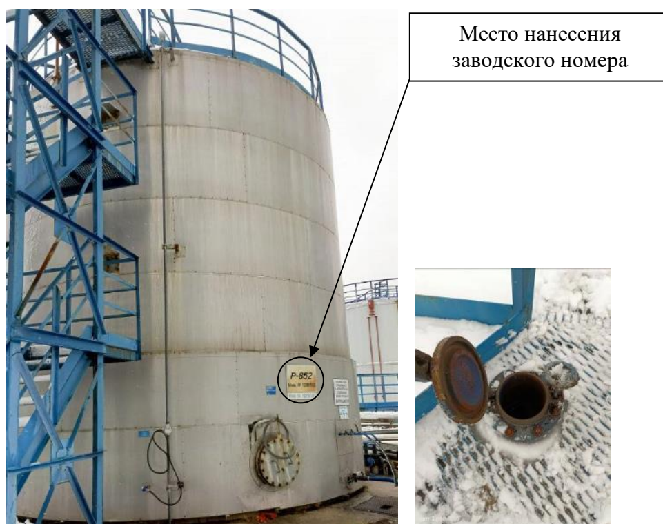
Р и с у н о к 1 – Общий вид резервуара с заводским номером P-852 и его замерного люка
