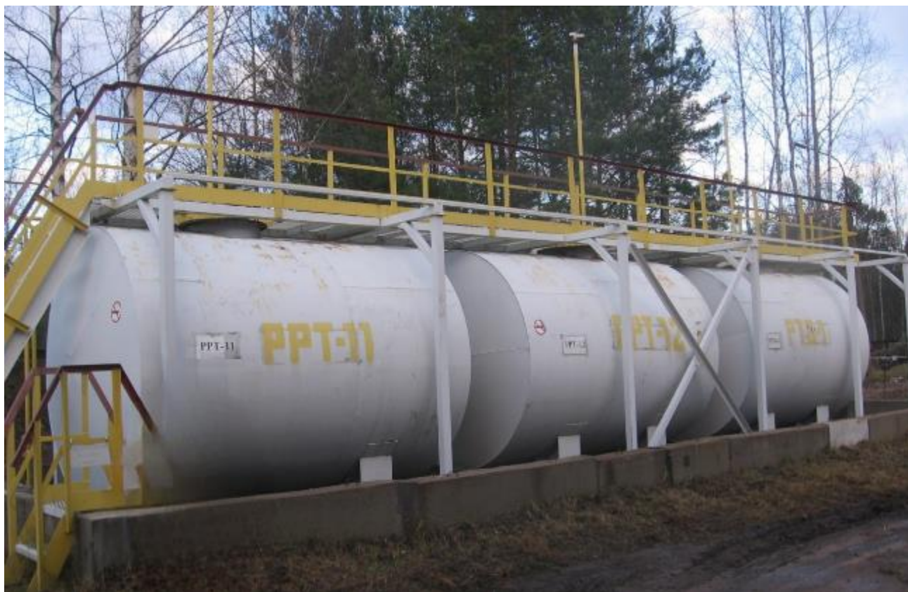
Рисунок 1 – Общий вид резервуаров РГС-25 с зав. №№ PPT-11, PPT-12, РТБ-1
