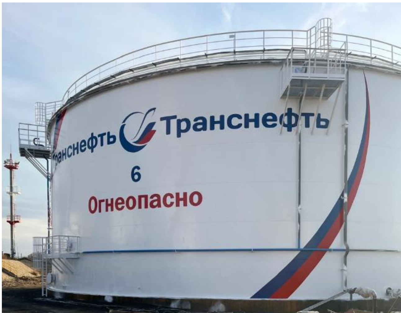
Рисунок 1 – Общий вид резервуара РВСП-10000 № 6
