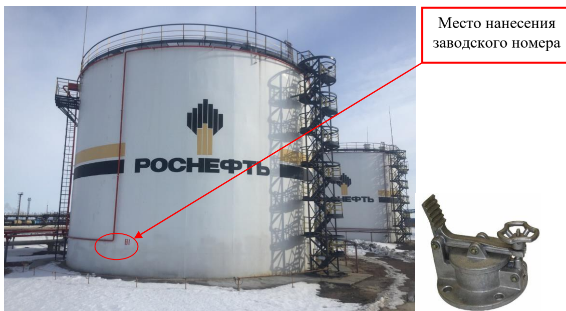
Рисунок 2 – Общий вид резервуара и замерного люка РВСП-5000 зав. № 81
