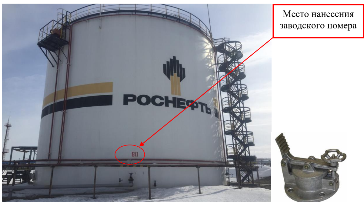
Рисунок 1 – Общий вид резервуара и замерного люка РВСП-5000 зав. № 80
