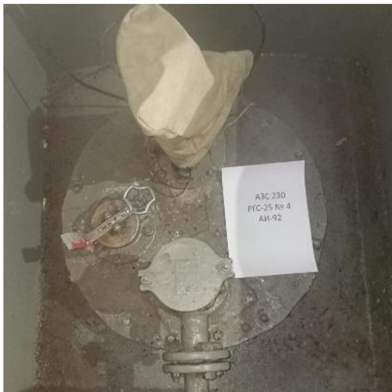
Рисунок 2 – Горловина резервуара РГС-25 зав.№ 4
