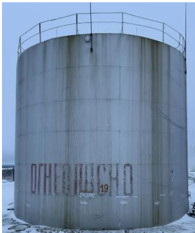
Рисунок 1 – Общий вид резервуара РВС-700 № 19
