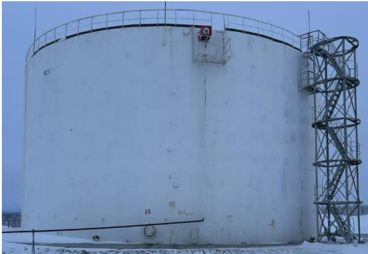
Рисунок 2 – Общий вид резервуара РВС-5000 № 28
