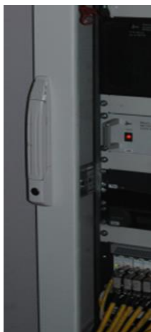
Рисунок 2 – Запирающий механизм стойки приборной
