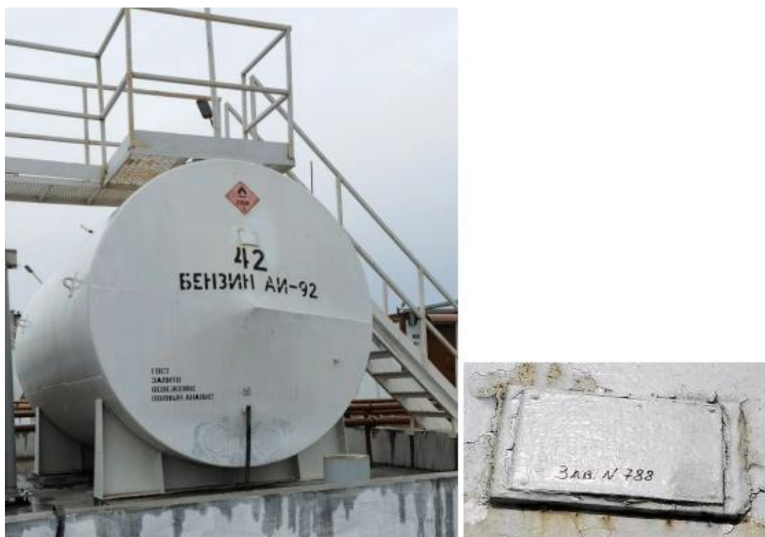
Рисунок 2 - Общий вид резервуаров РГС-25 зав. № 788 с местом нанесения заводского номера
