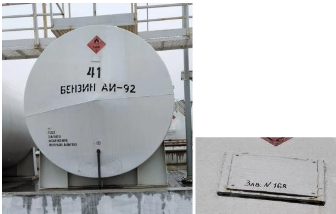
Рисунок 1 - Общий вид резервуаров РГС-25 зав. № 168 с местом нанесения заводского номера
