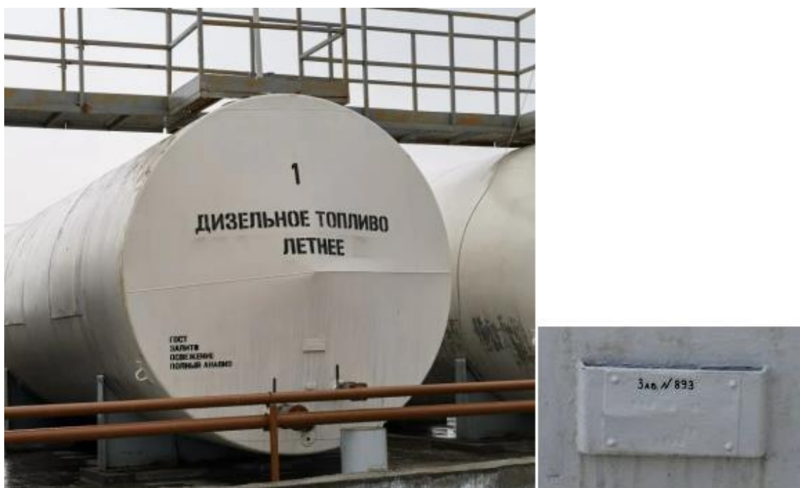
Рисунок 19 - Общий вид резервуаров РГС-75 зав. № 893 с местом нанесения заводского номера Пломбирование резервуаров РГС-75 не предусмотрено.
