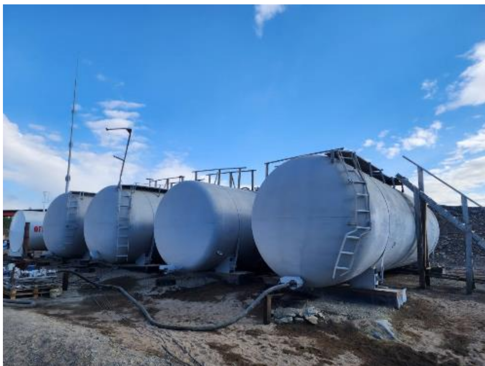
Рисунок 2 - Общий вид резервуаров с заводскими номерами 1, 2, 3, 4
