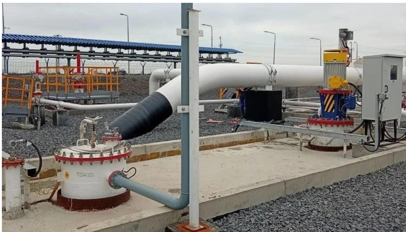
Рисунок 3 – Горловины и измерительный люк резервуара ЕП-40-2400-1100-А-С0-У1 зав.№ 359 Пломбирование резервуара ЕП-40-2400-1100-А-С0-У1 не предусмотрено
