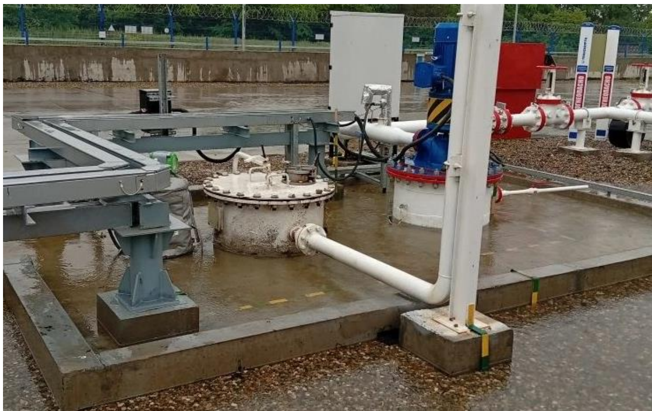
Рисунок 3 – Горловины и измерительный люк резервуара ЕП-20-2400-650-А-С-У1 зав.№ 7304 Пломбирование резервуара ЕП-20-2400-650-А-С-У1 не предусмотрено
