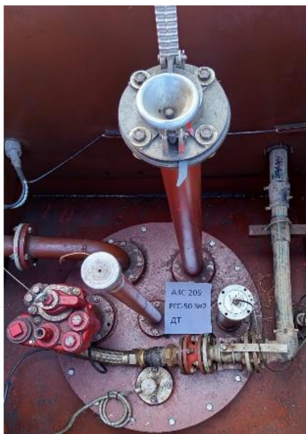
Рисунок 2 – Горловины резервуаров РГС-50 зав.№№ 1, 2
