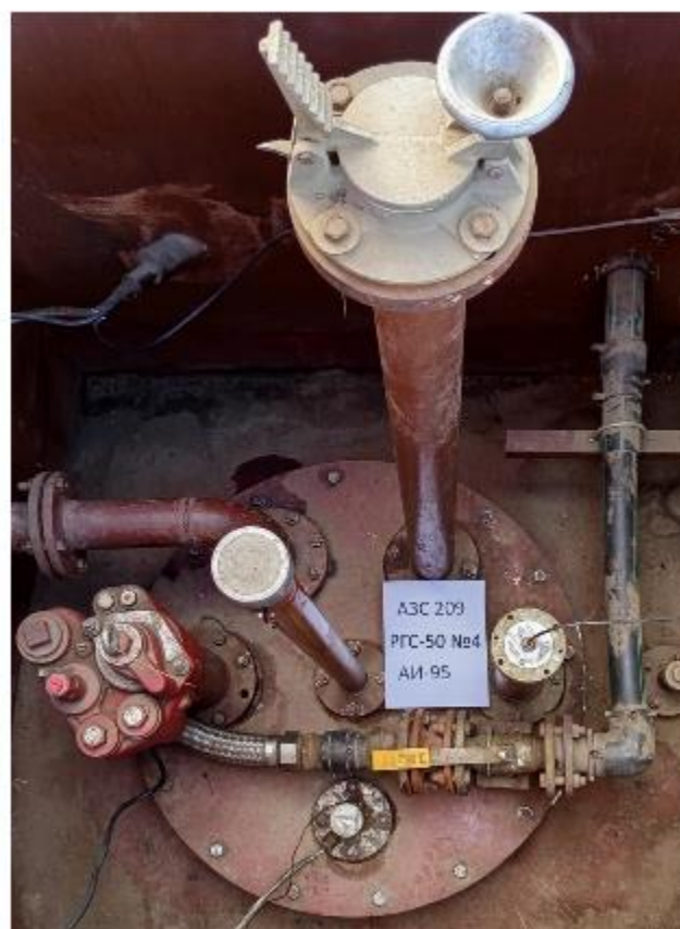
Рисунок 3 – Горловины резервуаров РГС-50 зав.№№ 3, 4
