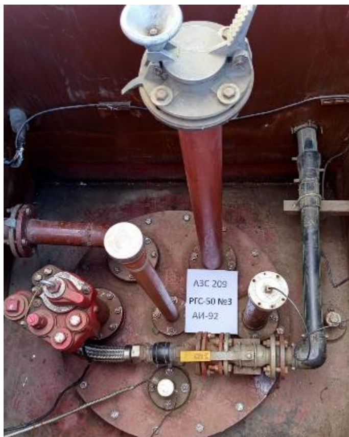
Рисунок 3 – Горловины резервуаров РГС-50 зав.№№ 3, 4
