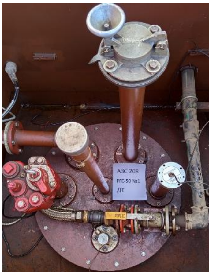
Рисунок 2 – Горловины резервуаров РГС-50 зав.№№ 1, 2
