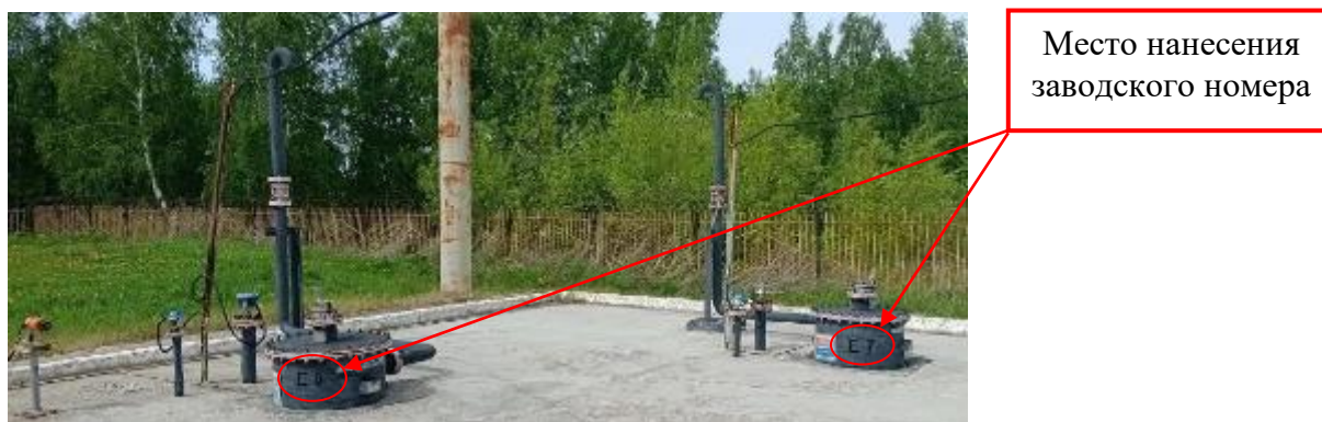
Рисунок 2 – Общий вид резервуаров и замерных люков РГС-100 зав. №№ Е-7, Е-8
