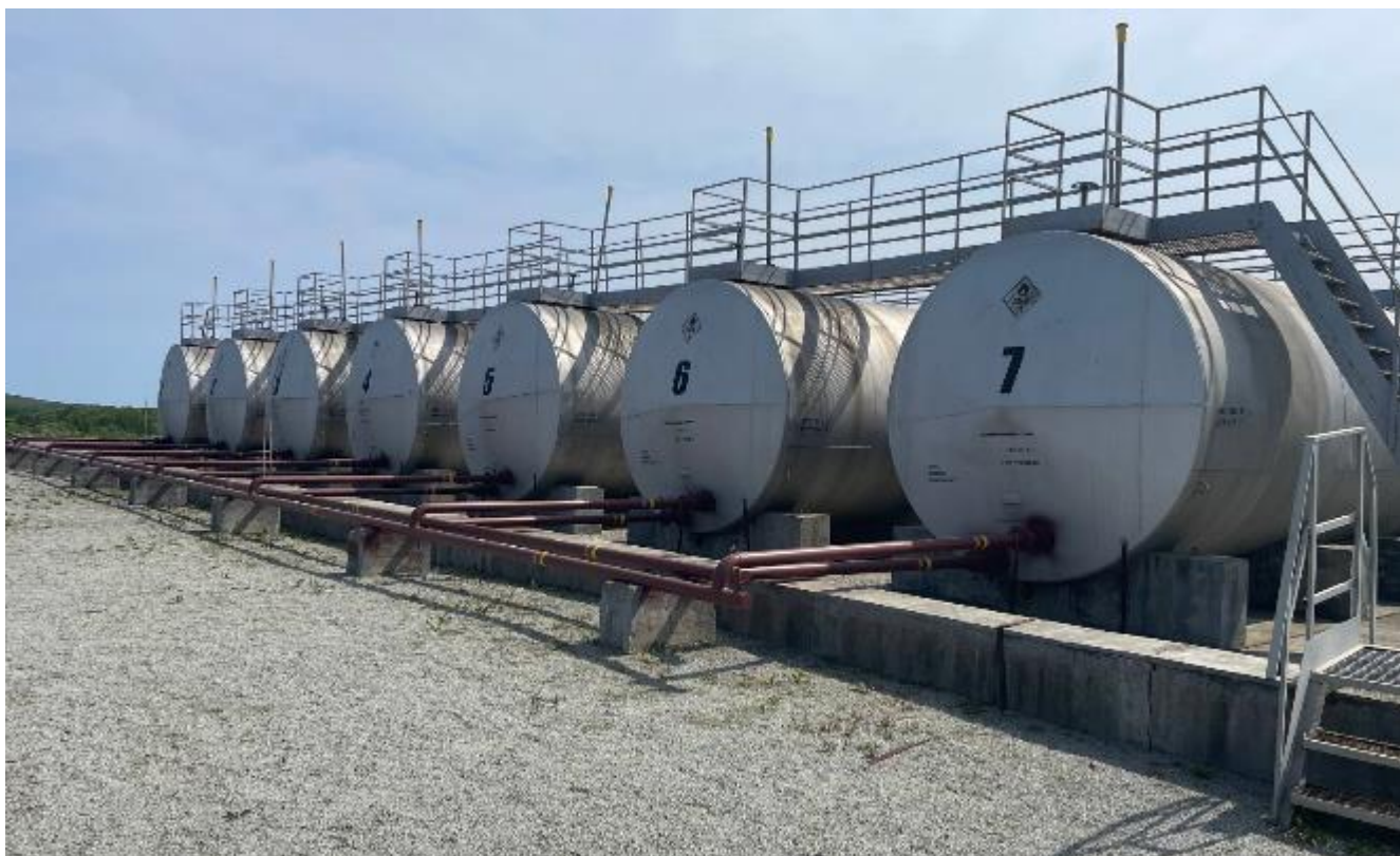
Рисунок 1 – Общий вид резервуаров Р-75 зав. №№ 1, 2, 3, 4, 5, 6, 7
