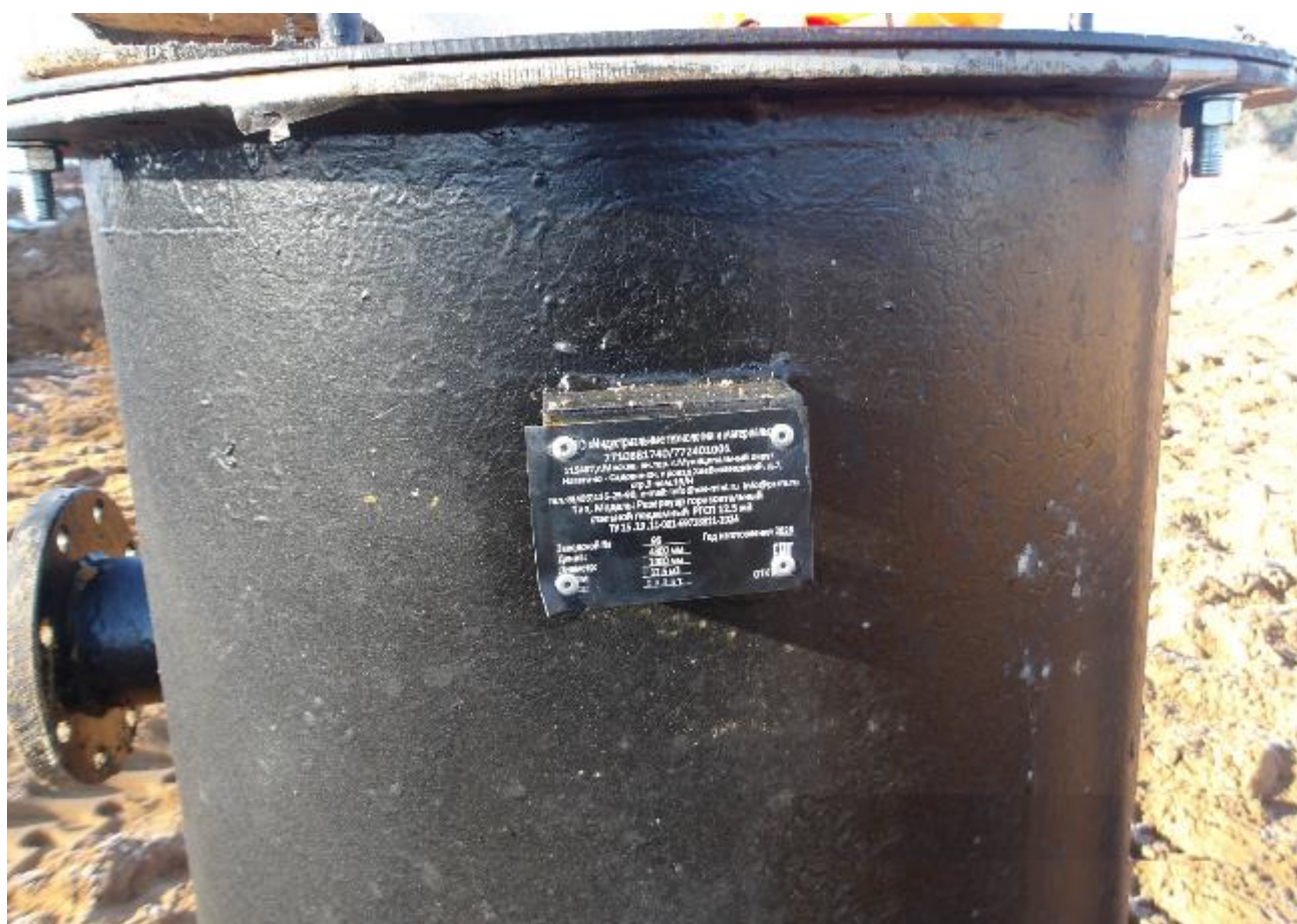
Рисунок 2 – Горловина и маркировочная табличка резервуара РГСП-12,5 зав.№ 96
