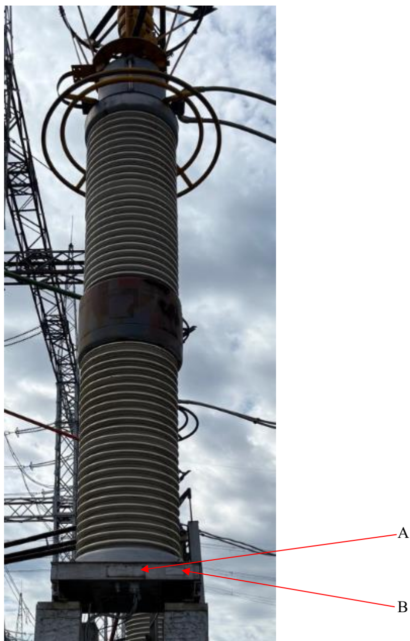
Рисунок 1 – Общий вид средства измерений, обозначение места пломбировки от несанкционированного доступа (А) и обозначение места нанесения заводских номеров (В)
