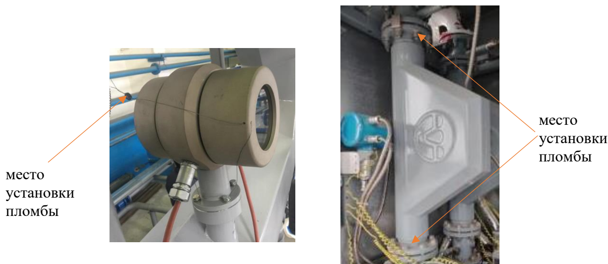
Рисунок 3 – Схема пломбировки счетчика-расходомера массового от несанкционированного доступа
